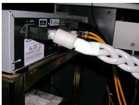
Entrata quasi orizzontale per il TNT-TTS. Il nastro non isola nulla, tiene al suo posto la ferrite. La IEC è totalmente riempita di silicone che, purtroppo, non si può dipingere ma la sicurezza viene innanzi tutto.
